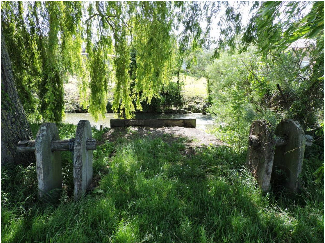
Le lavoir mobile vu depuis le nord-est.
