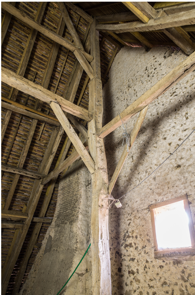
Un détail d'une ferme de la charpente.
