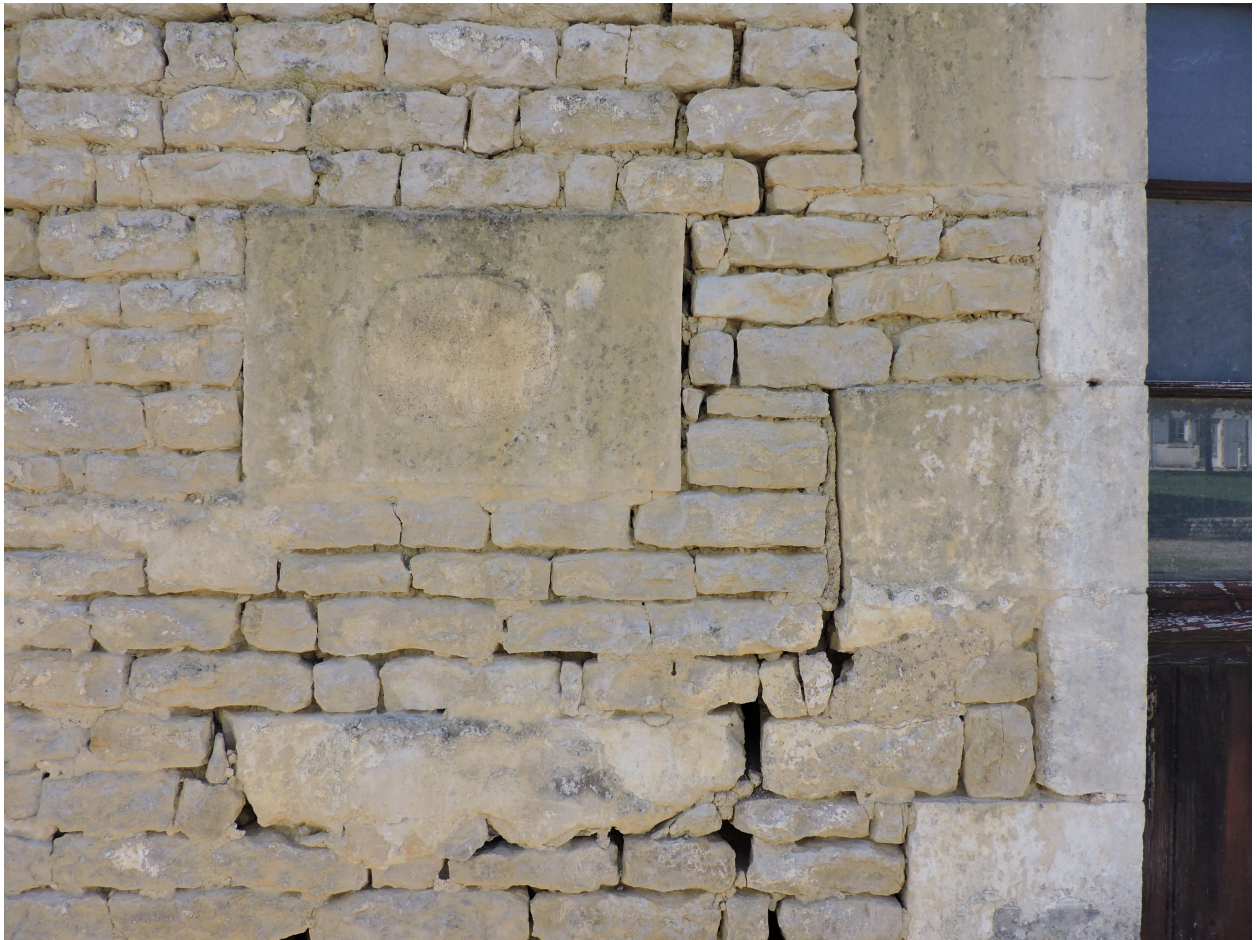
Vestiges de pierre d'évier dans l'angle nord-est du logis.
