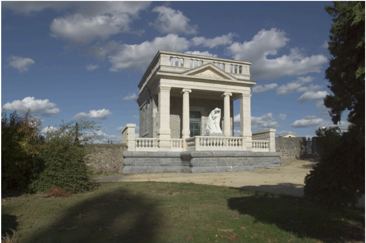
Vue d'ensemble depuis le sud.
