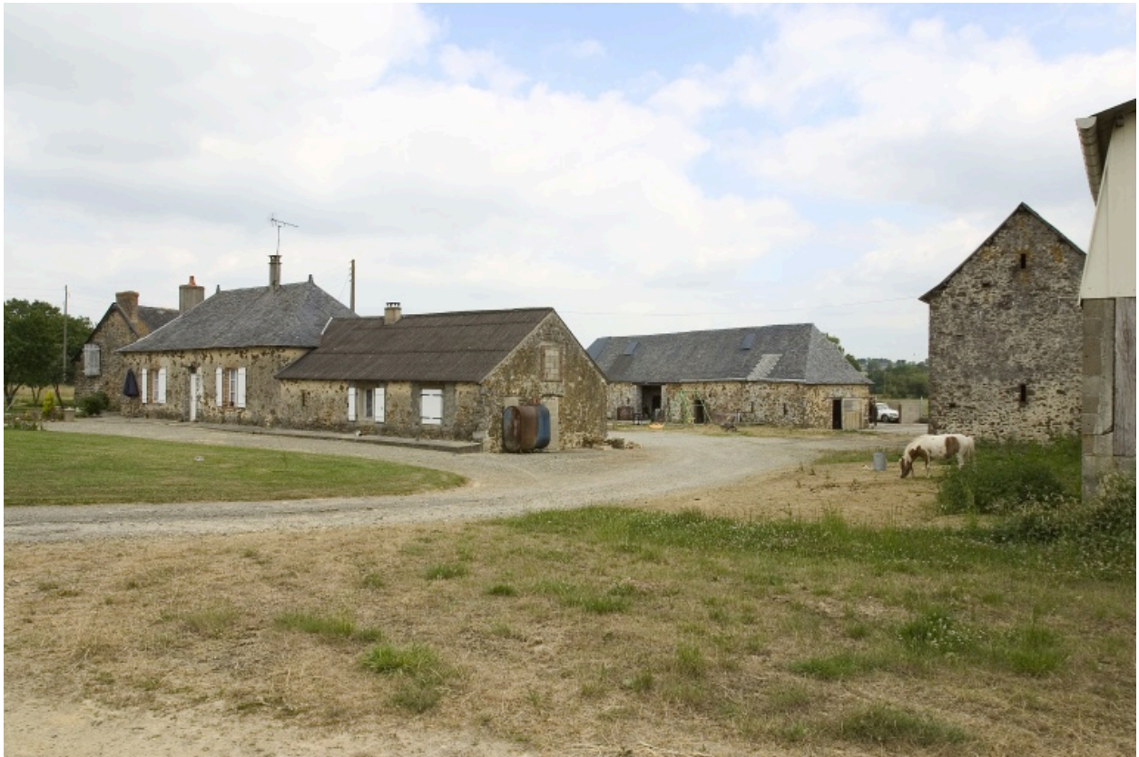
Vue d'ensemble depuis le chemin au sud-est : le pignon du fournil, le logis, l'étable-grange, le pignon de la seconde étable.
