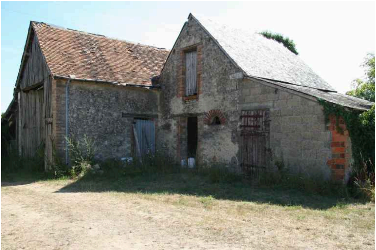
Maison n°2 : remises et hangar.
