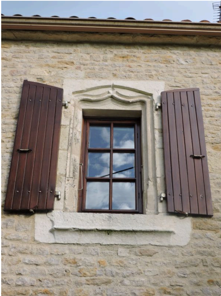
Une des deux baies avec linteau en accolade, sur la façade ouest du logis.
