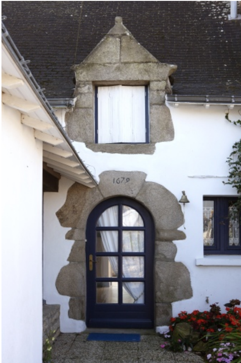
Vue du 3e logement (18 rue des Rigadeaux).
