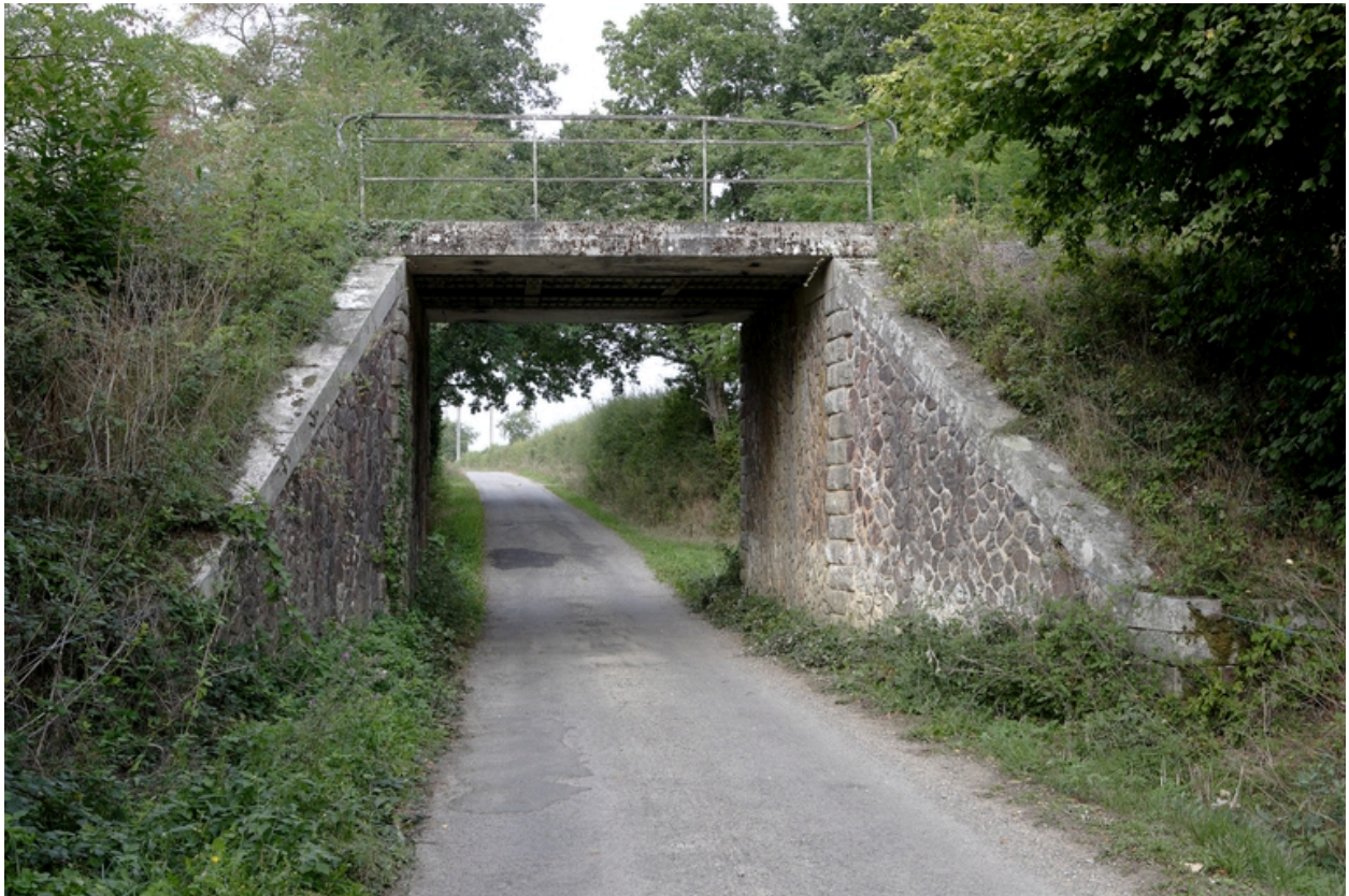
Pont-rail à poutres jumelles.
