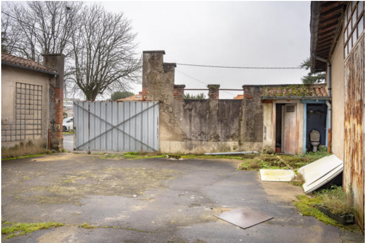
Cour intérieure et sanitaires.
