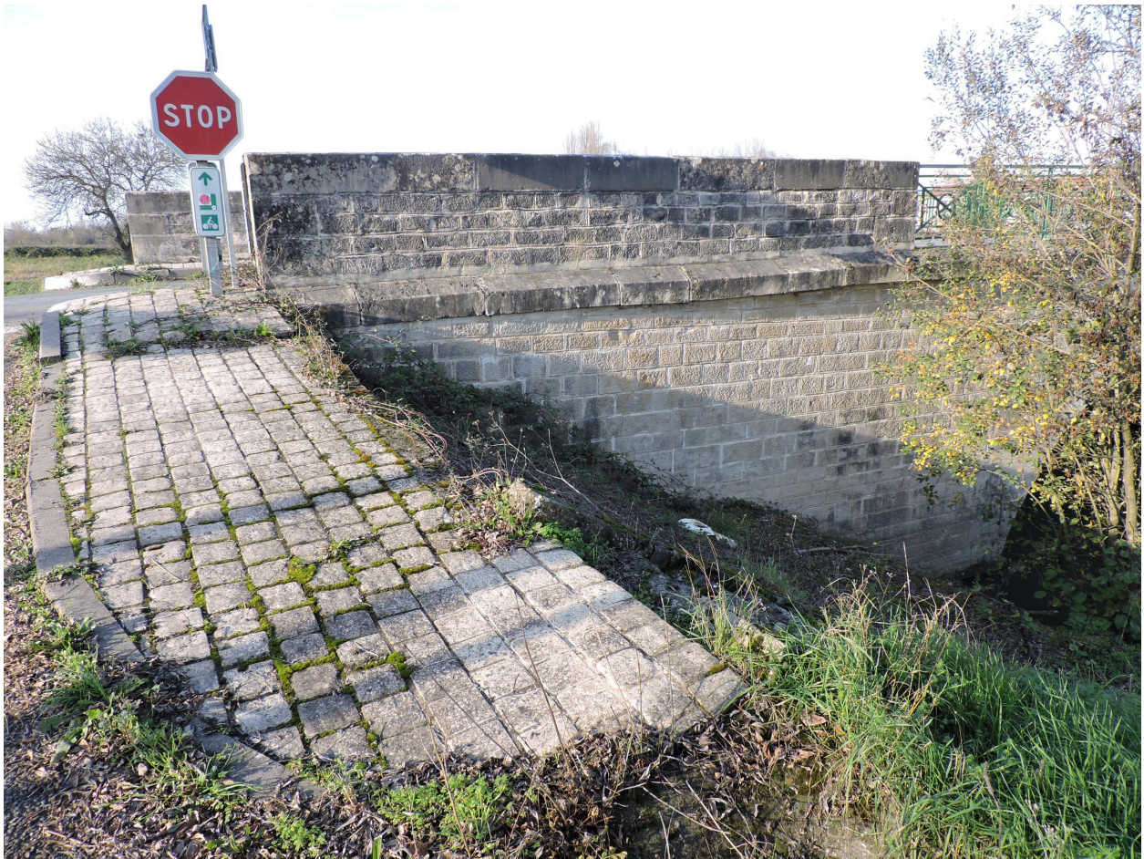
Parapet, maçonnerie et perré du grand pont, angle sud.
