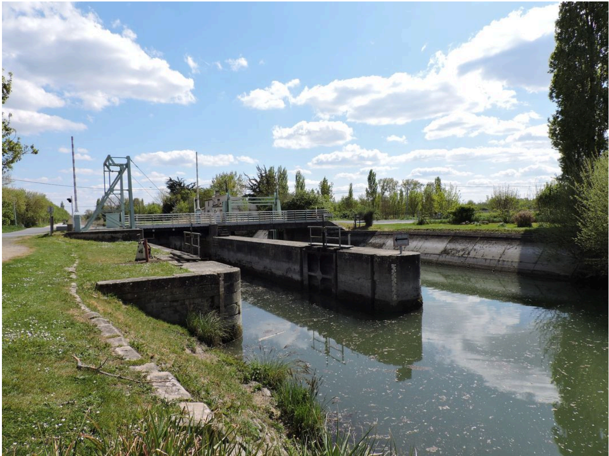
Le barrage éclusé du Mignon vu depuis l'aval, au nord.
