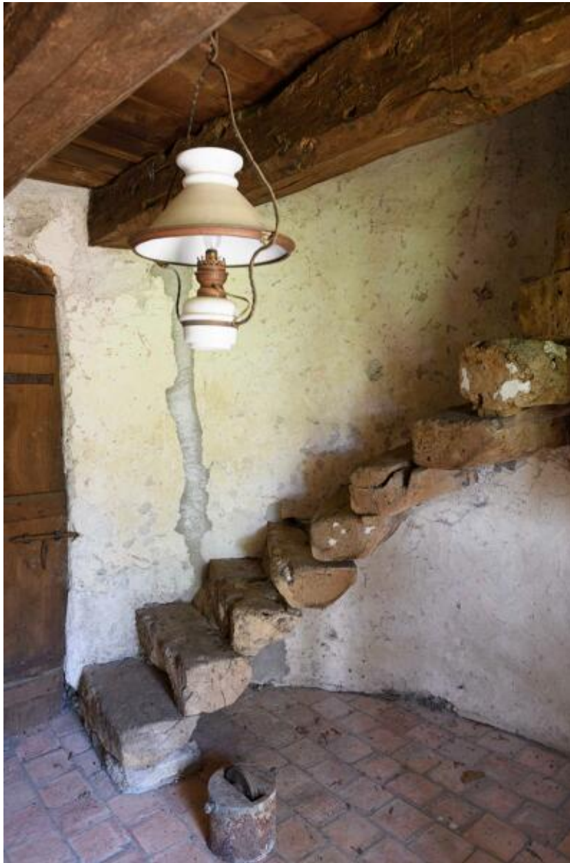
Moulin à farine dit moulin des Buttes (n° 1) ou moulin de l'Ouche-Neuve. Détail de l'escalier.
