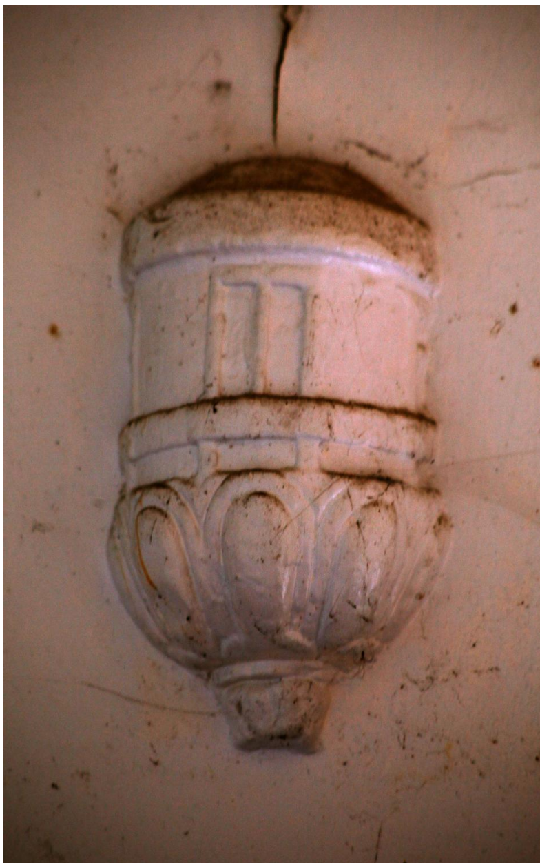
Rez-de-chaussée, voûte du vestibule : culot 7.
