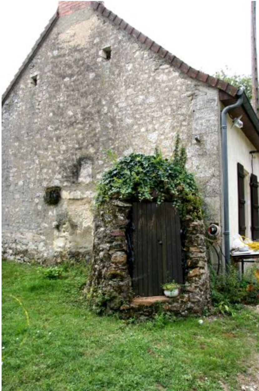
Maison 2 : pignon et puits.
