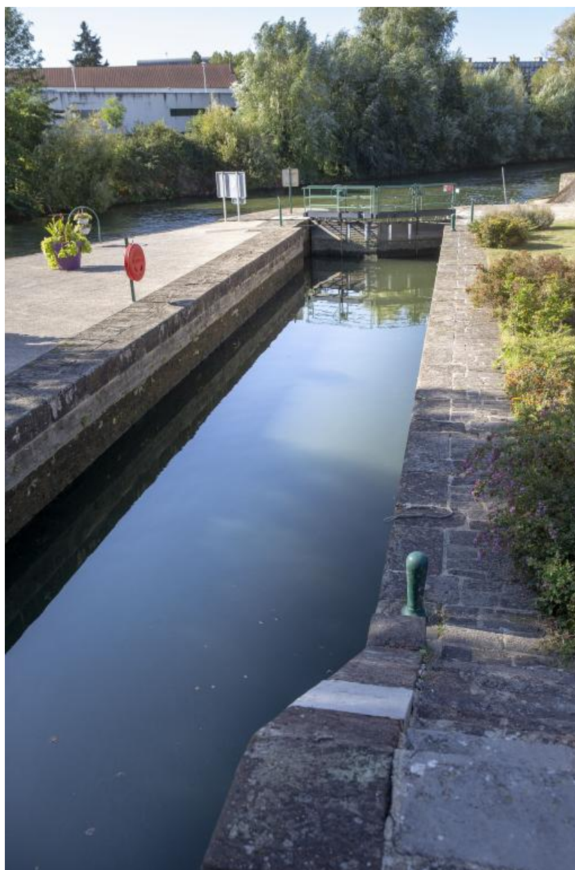
Vue du sas de l'écluse.
