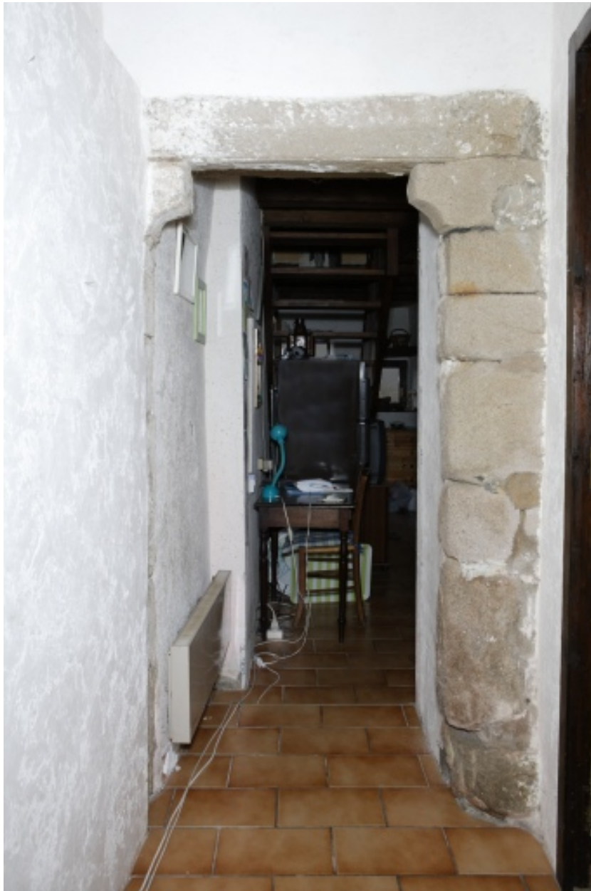
Détail de la porte est (4 rue de l'Aha).
