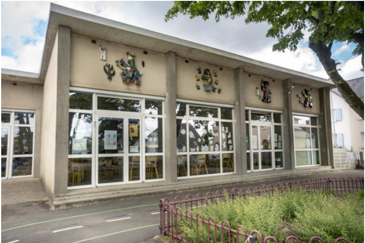
Vue des façades sur cour.
