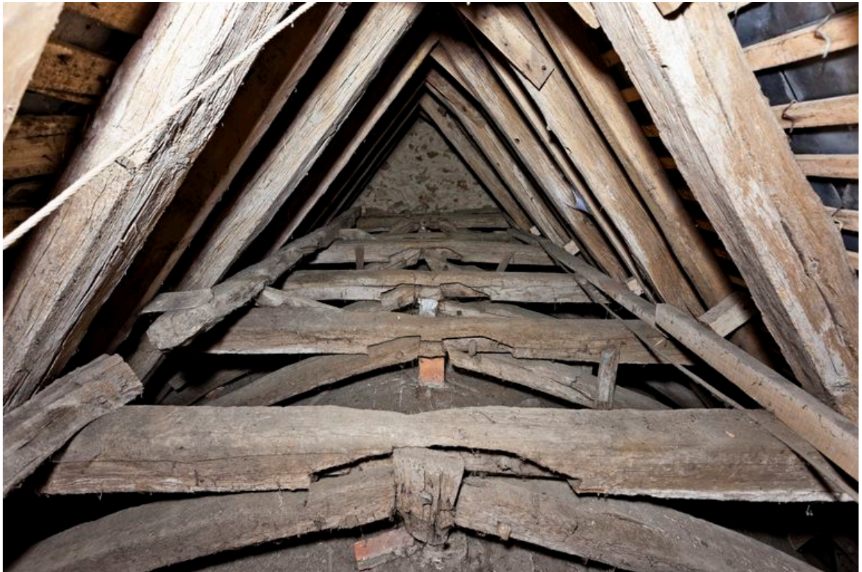
Charpente du choeur : vue d'ensemble depuis l'ouest à partie de la 6e ferme.
