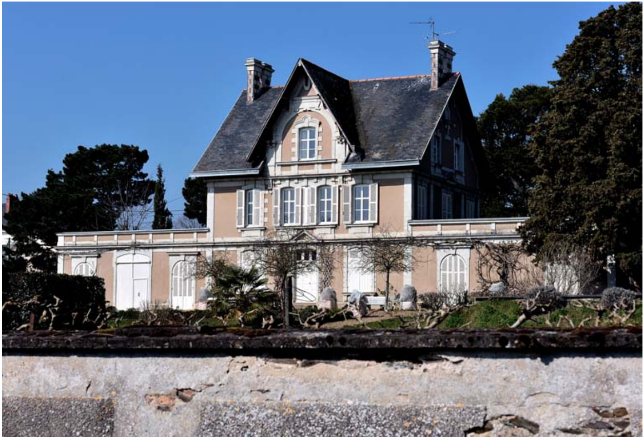
Vue d'ensemble depuis la Loire.
