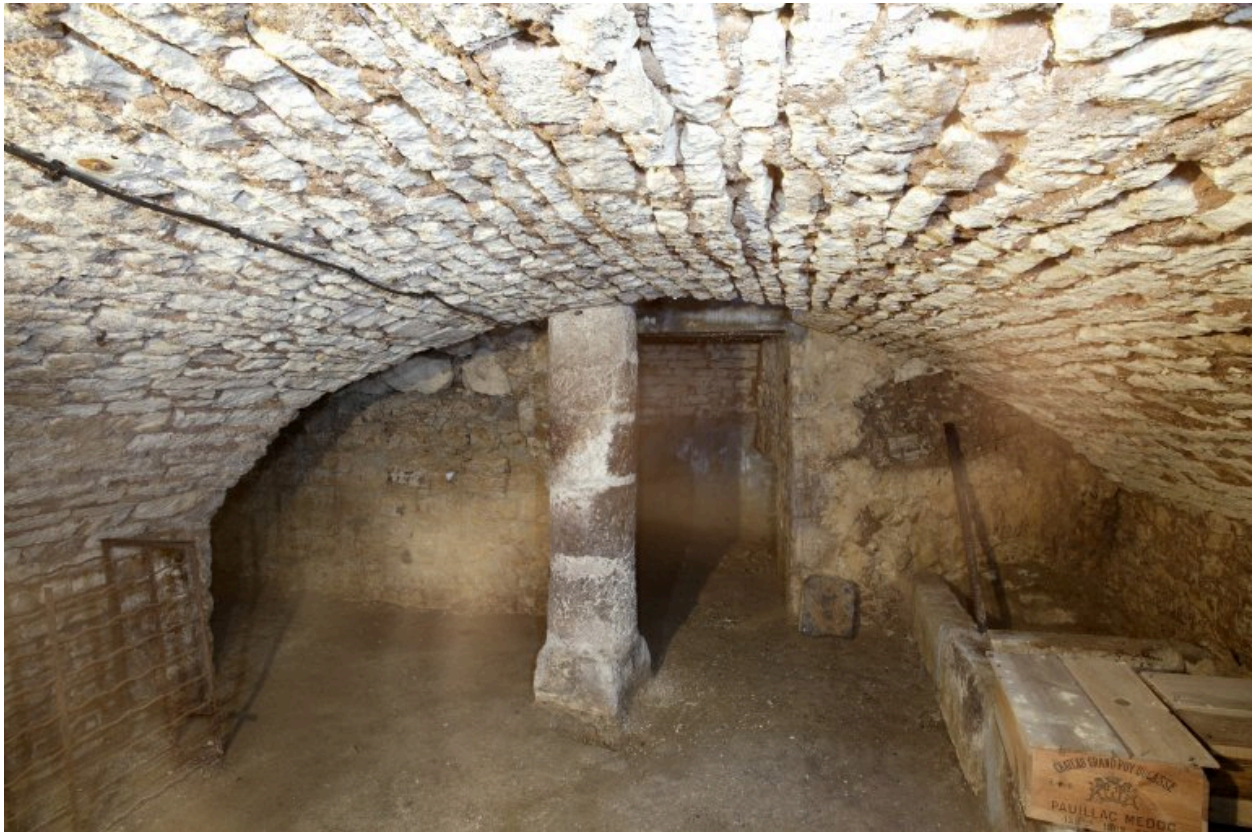
Vue prise du fond du sous-sol.
