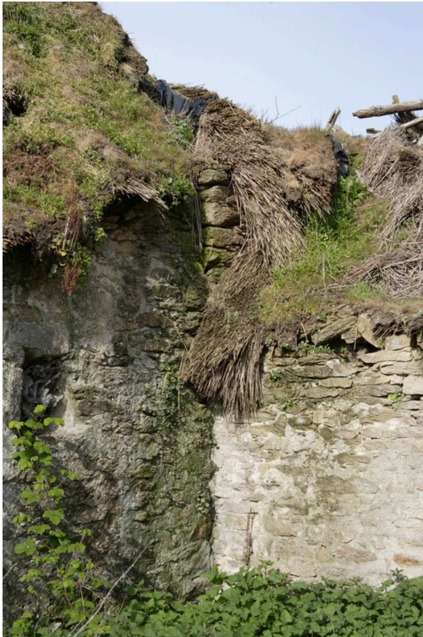
Détail de la liaison toit à porcs-étable dans l'angle nord-est.
