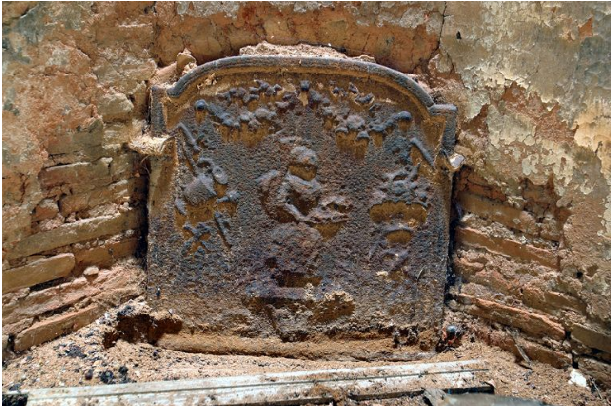
Etage de comble, pièce nord : la plaque de la cheminée.
