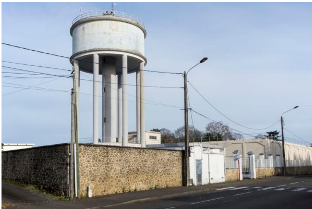
Vue du réservoir d'eau dit de Gazonfier.
