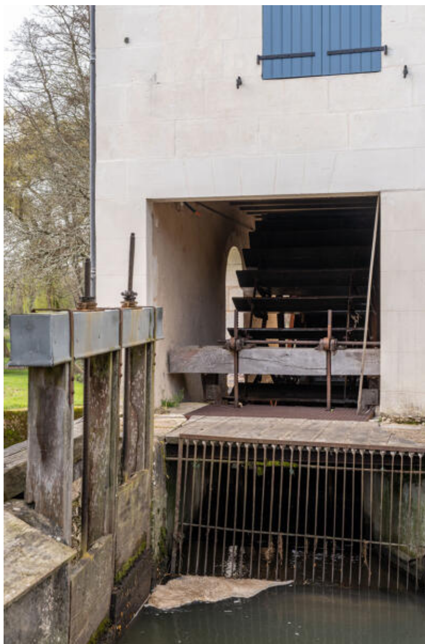
La cage de la roue et les vannes.
