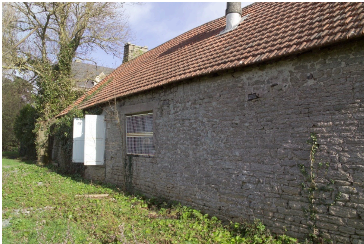
Bâtiment ouest. Vue du mur gouttereau ouest.
