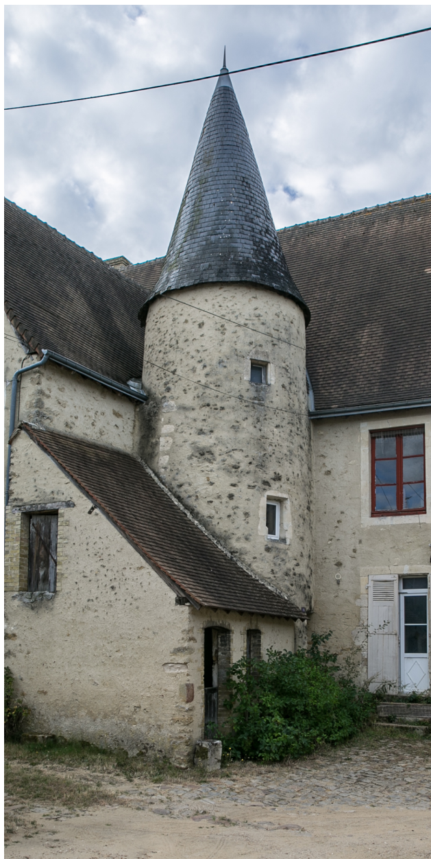
La demeure principale, la tour d'escalier.
