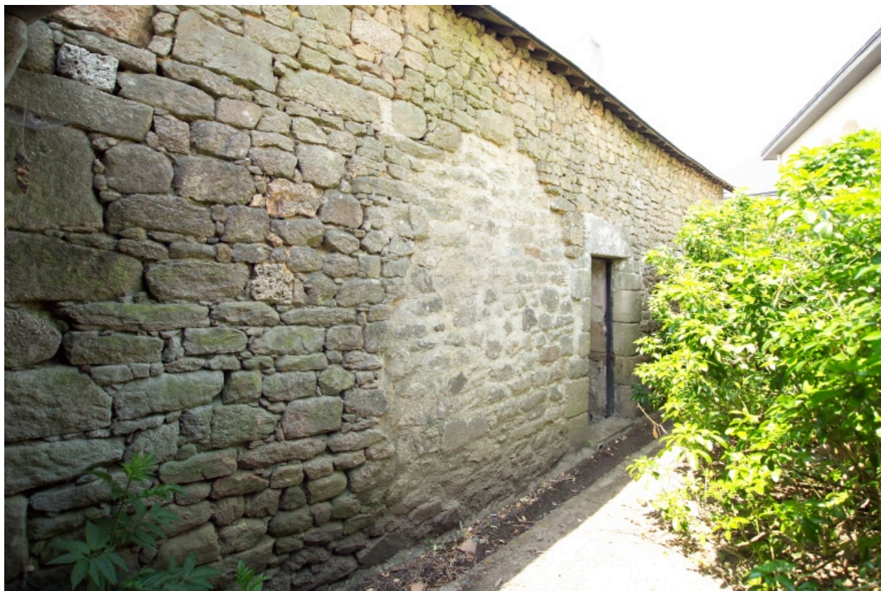
Bâtiment nord, façade postérieure.
