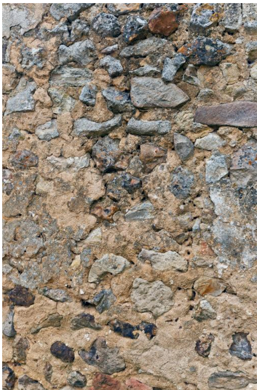
Détail d'une maçonnerie de moellons de silex enduits.
