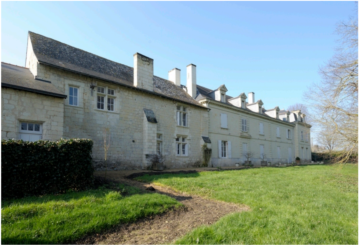
Logis. Façade postérieure.
