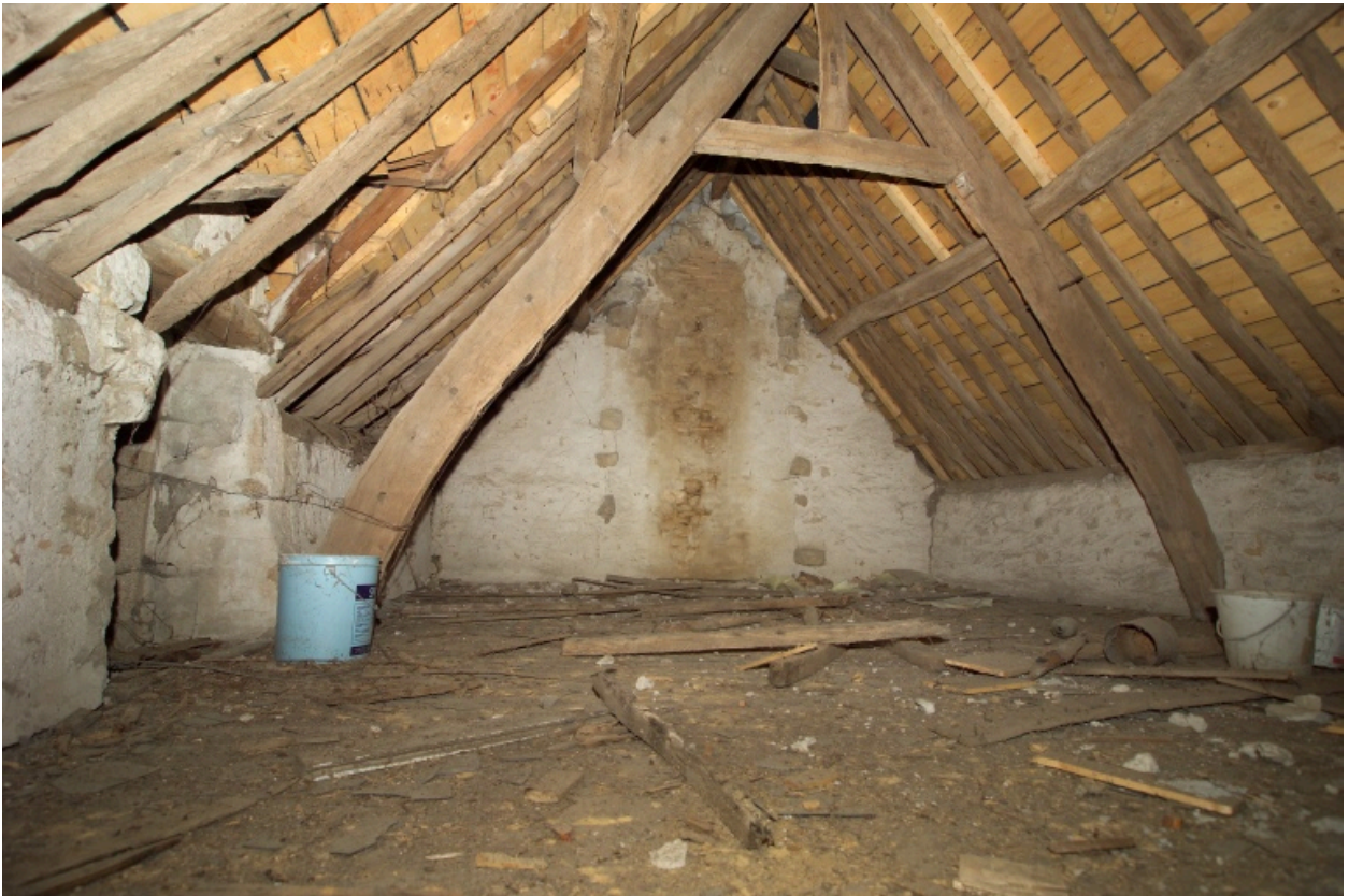
Bâtiment nord, charpente.
