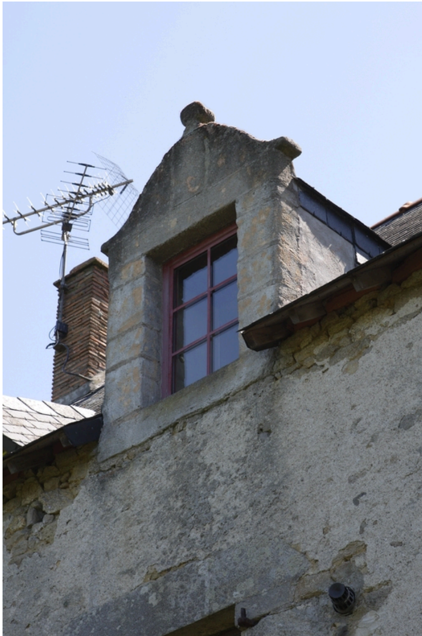
Logis. Détail de la lucarne reconstruite après 1970 de la façade nord.
