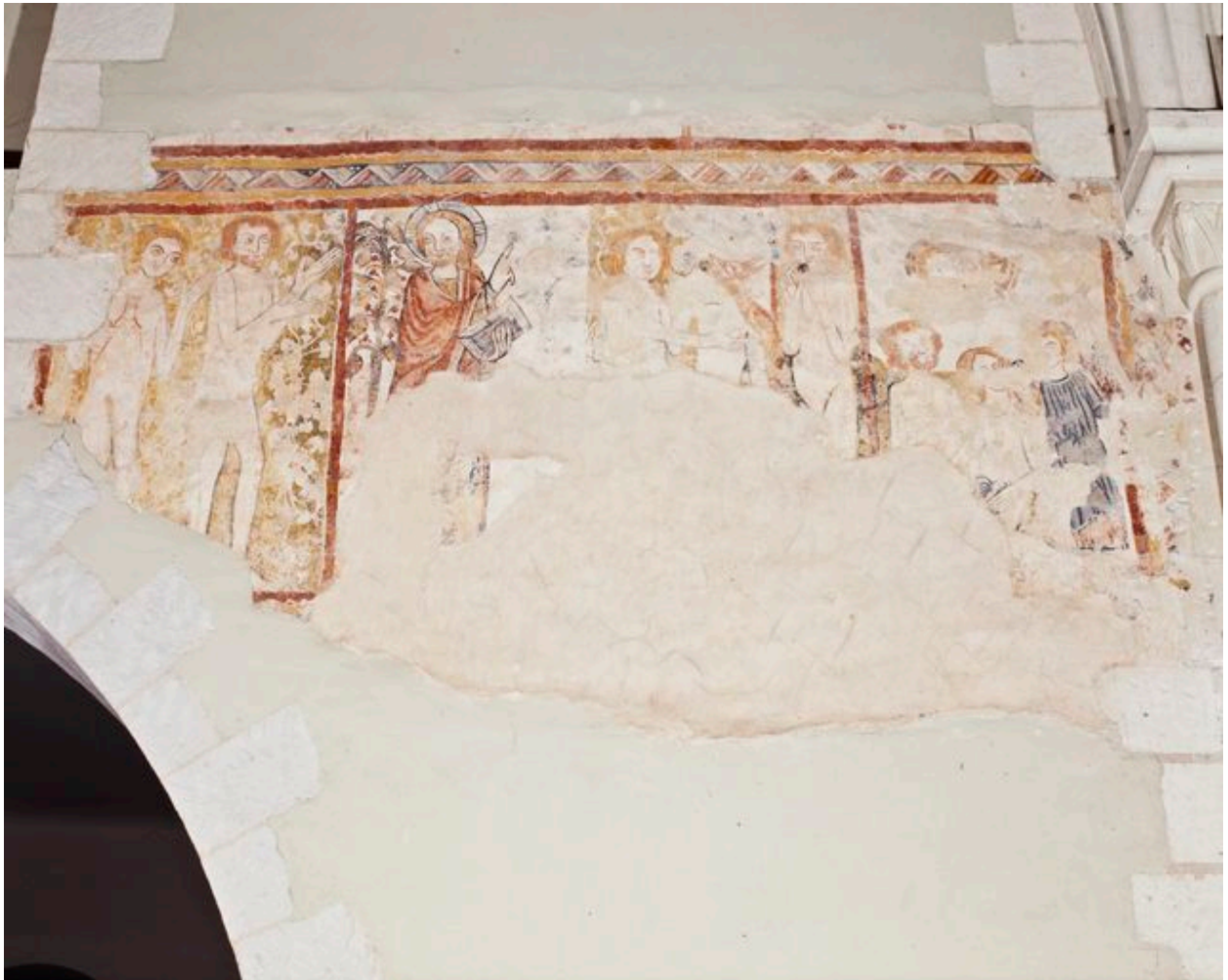
Mur nord. Histoire de la Faute : vue d'ensemble.
