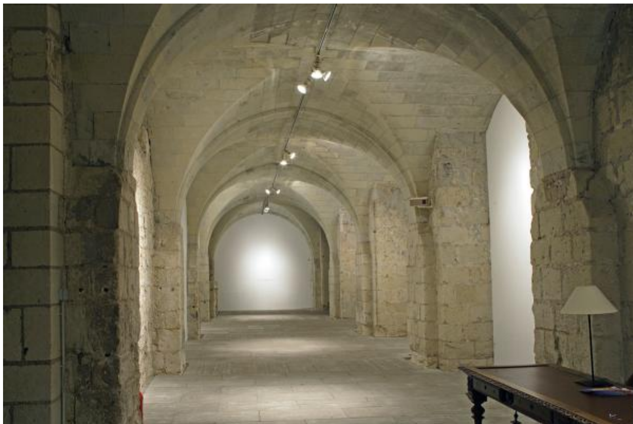
Eglise, partie basse du collatéral sud avec les voûtes du 17 e siècle, vue d'est en ouest.
