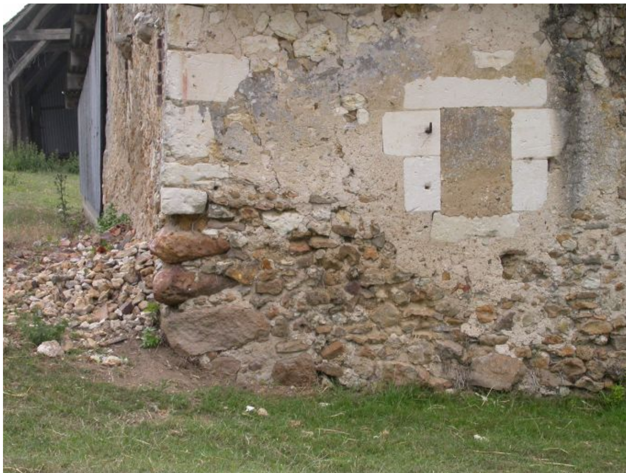
Façade antérieure, détail mise en oeuvre des blocs de silex en chaînage d'angle.
