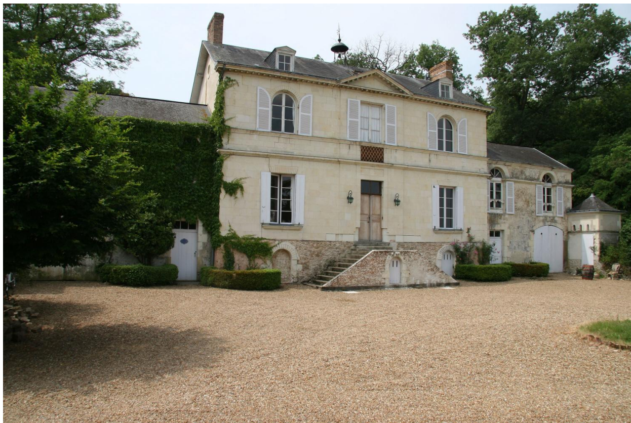
Le logis principal : vue d'ensemble.
