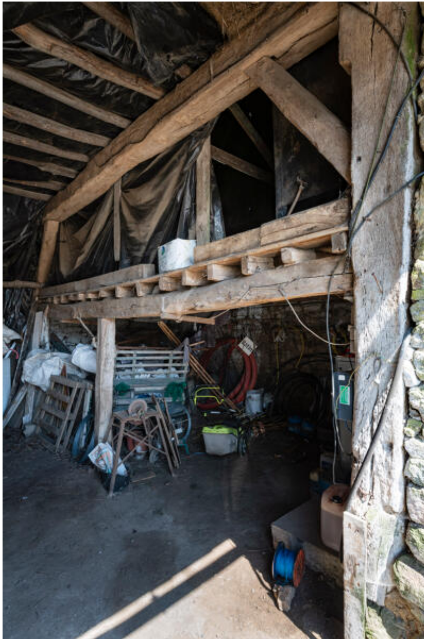
Grange-étable occidentale, ferme nord, vue depuis l'ouest.
