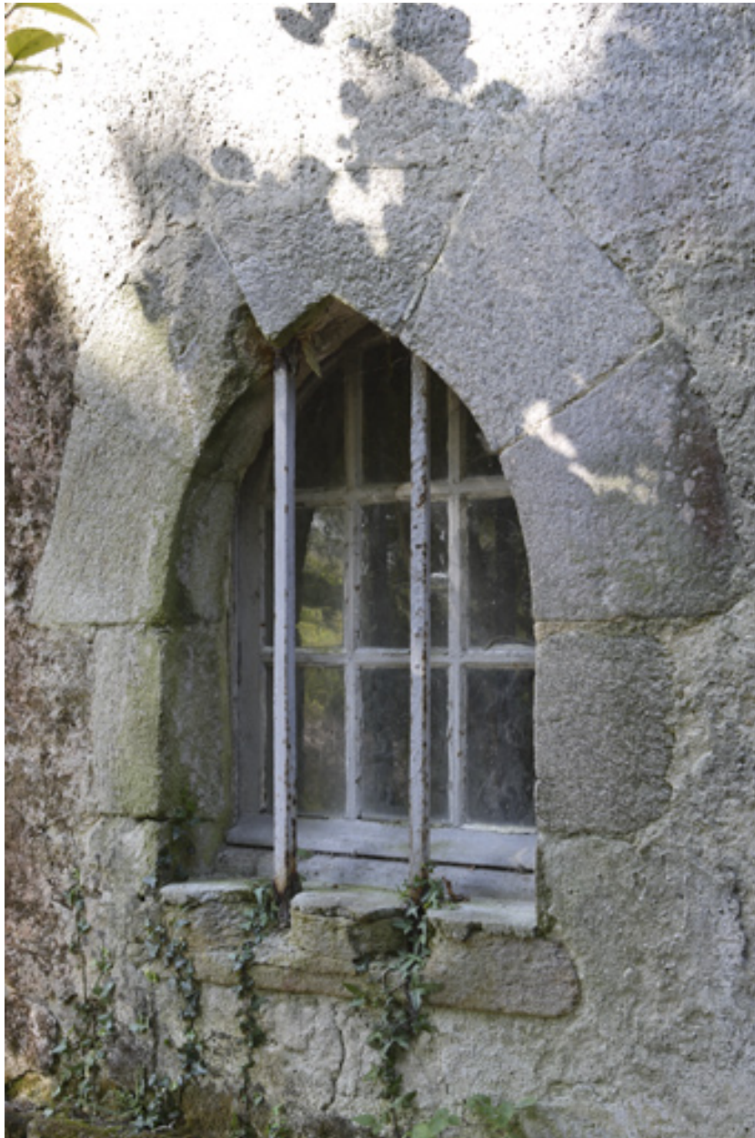
Logis. Façade ouest. Baie.
