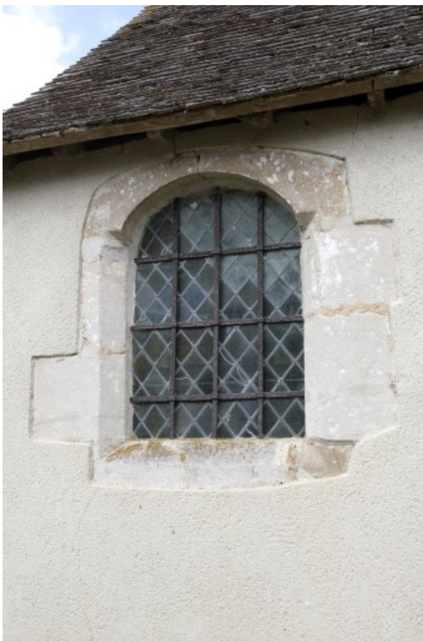
Sacristie, fenêtre postérieure droite, remaniement de 1823-25 ?
