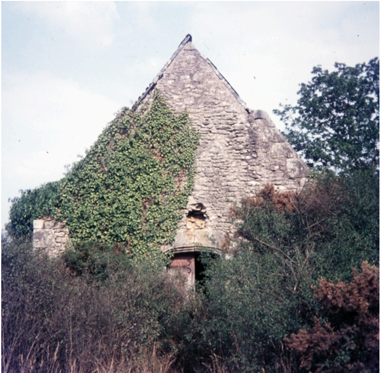
Vue du pignon ouest (extérieur). Photo. Y. Maurice, 1976.
