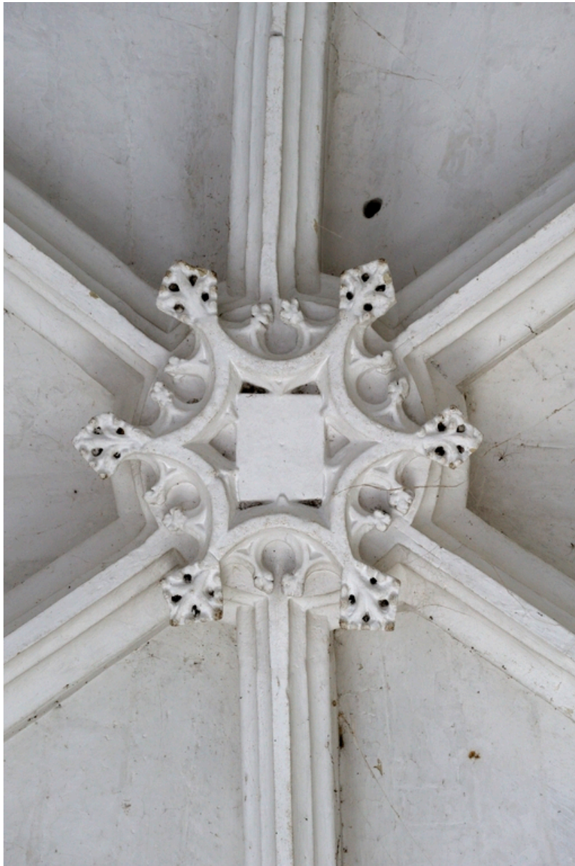
Ancienne chapelle nord (fin XVe siècle), étage. Voûte : clef.
