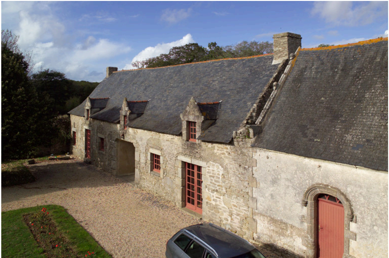
Vue cavalière du premier corps de communs depuis le sud.
