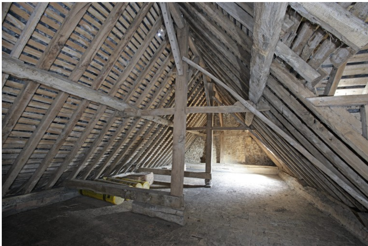
Aile postérieure, comble : la charpente.
