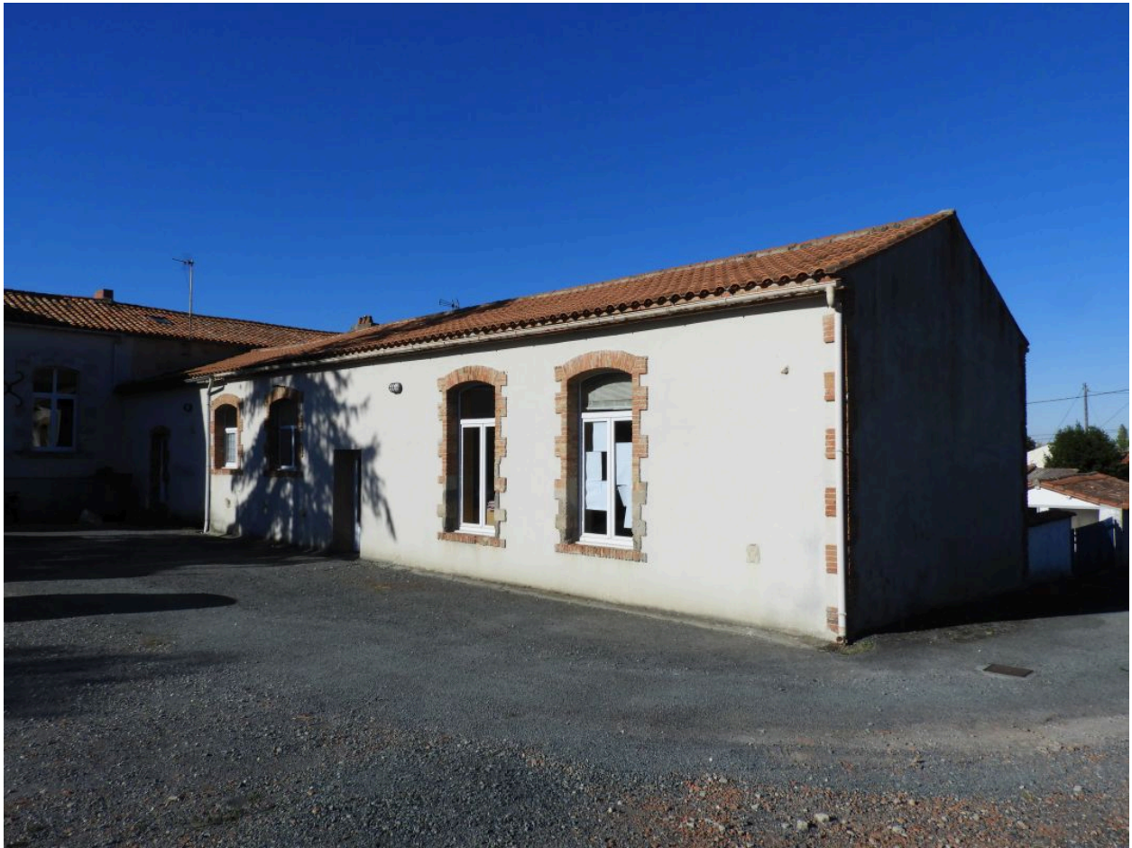
Le bâtiment de classes au nord de l'ensemble vu depuis le nord-est.
