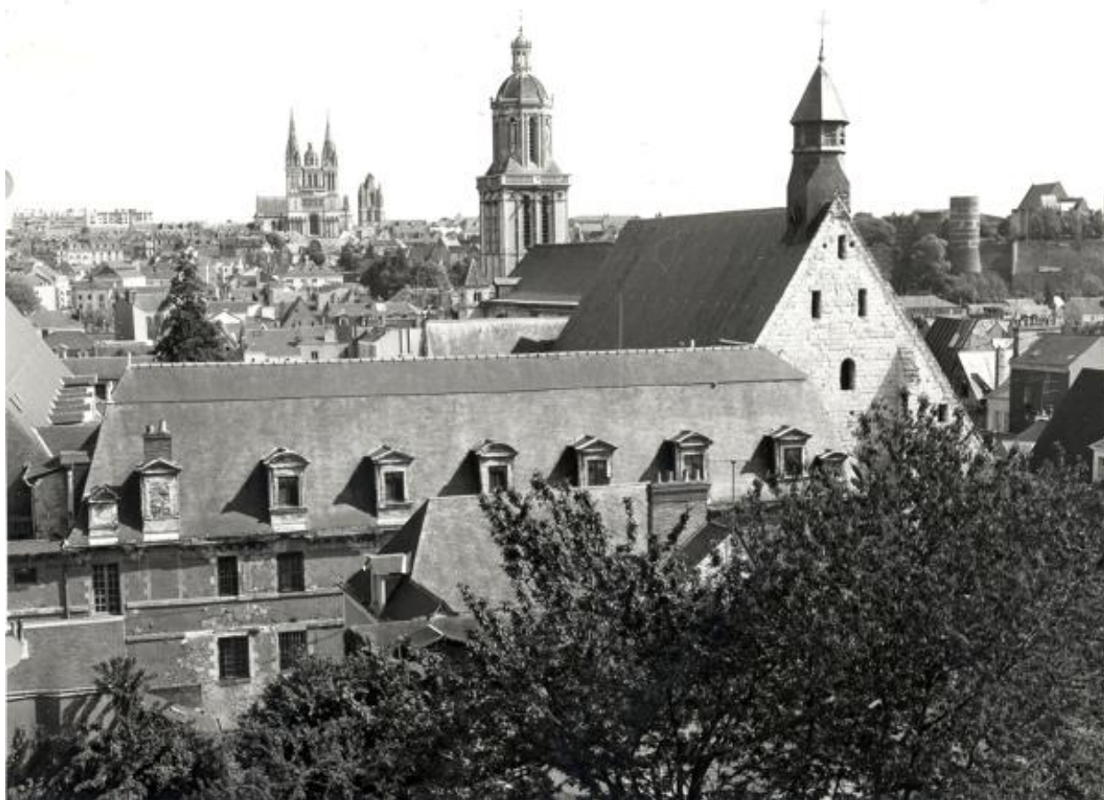
Vue d'ensemble depuis l'ouest, à hauteur des jardins de Montiron.
