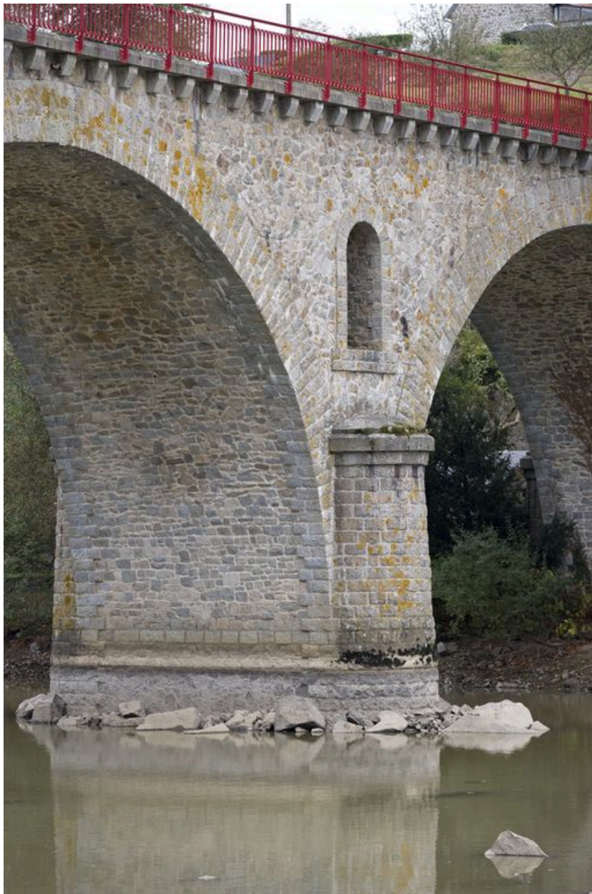
Vue d'une pile, pendant les écoures de 2009.
