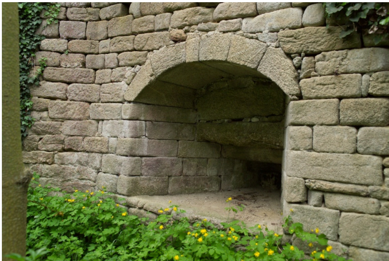
Ouverture de tir du mur d'enceinte de ville au sud du jardin.
