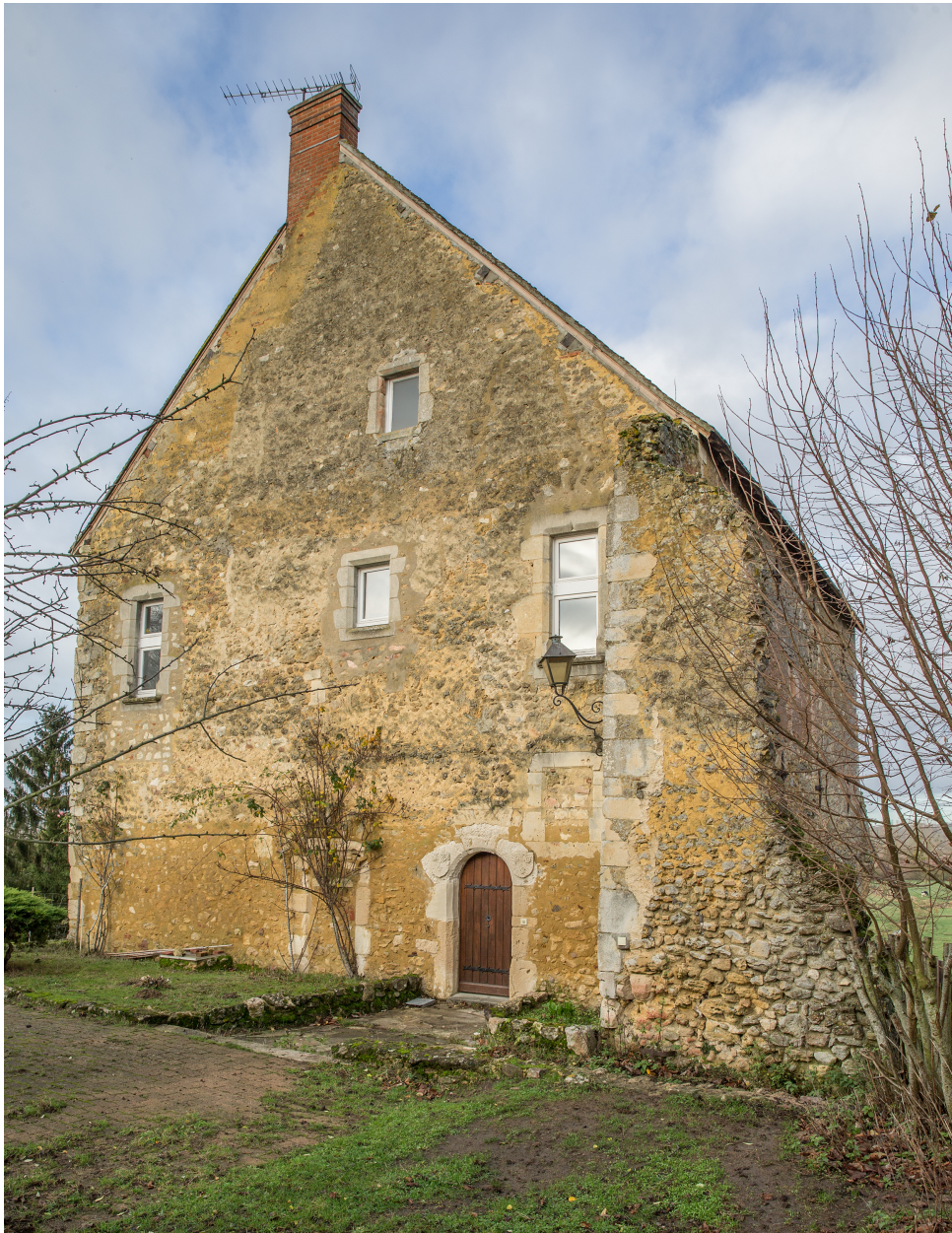
Le pignon sud-est.
