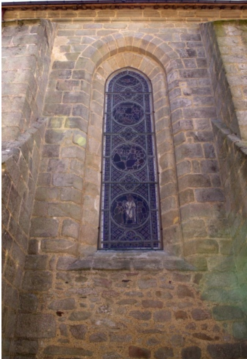
Mur nord, détail de la baie de la seconde travée.
