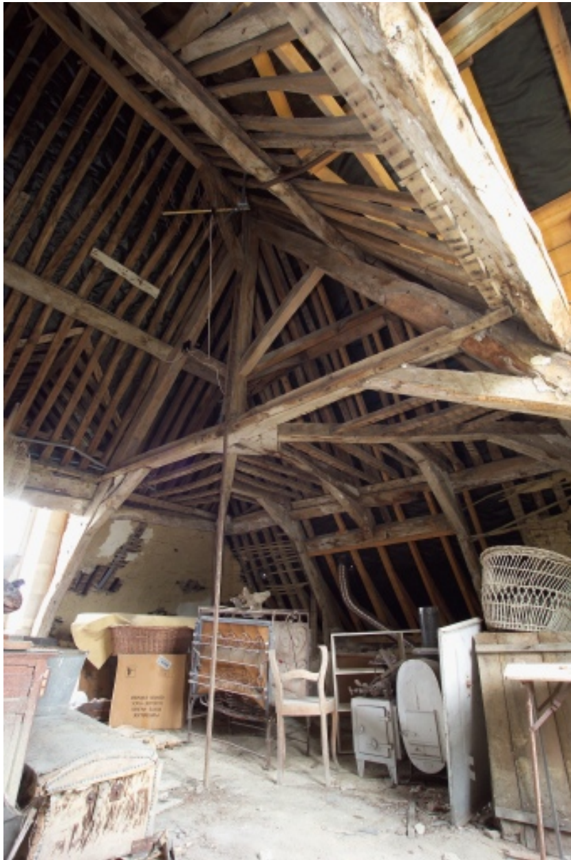
Vue de la croupe de charpente de l'aile sud.
